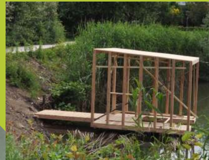
Pristan na Koseškem bajerju v času gradnje.
